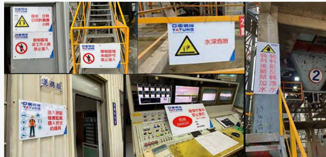
作業場所提供安全衛生防護器具及安全標示
